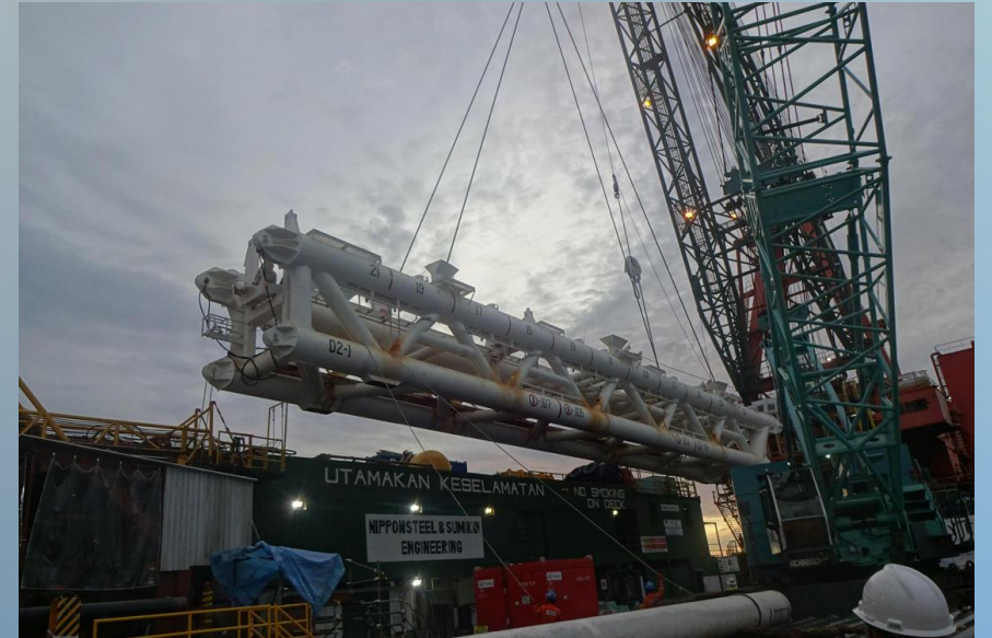
海底パイプラインを吊り下げている （日鉄エンジニアリング株式会社ホームページから）
